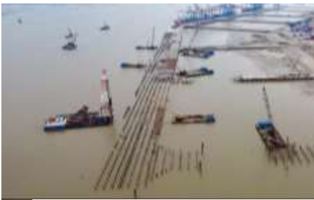
Hình 4. Cảng Nam Đình Vũ giai đoạn 3 vào đầu tháng 06/2025
